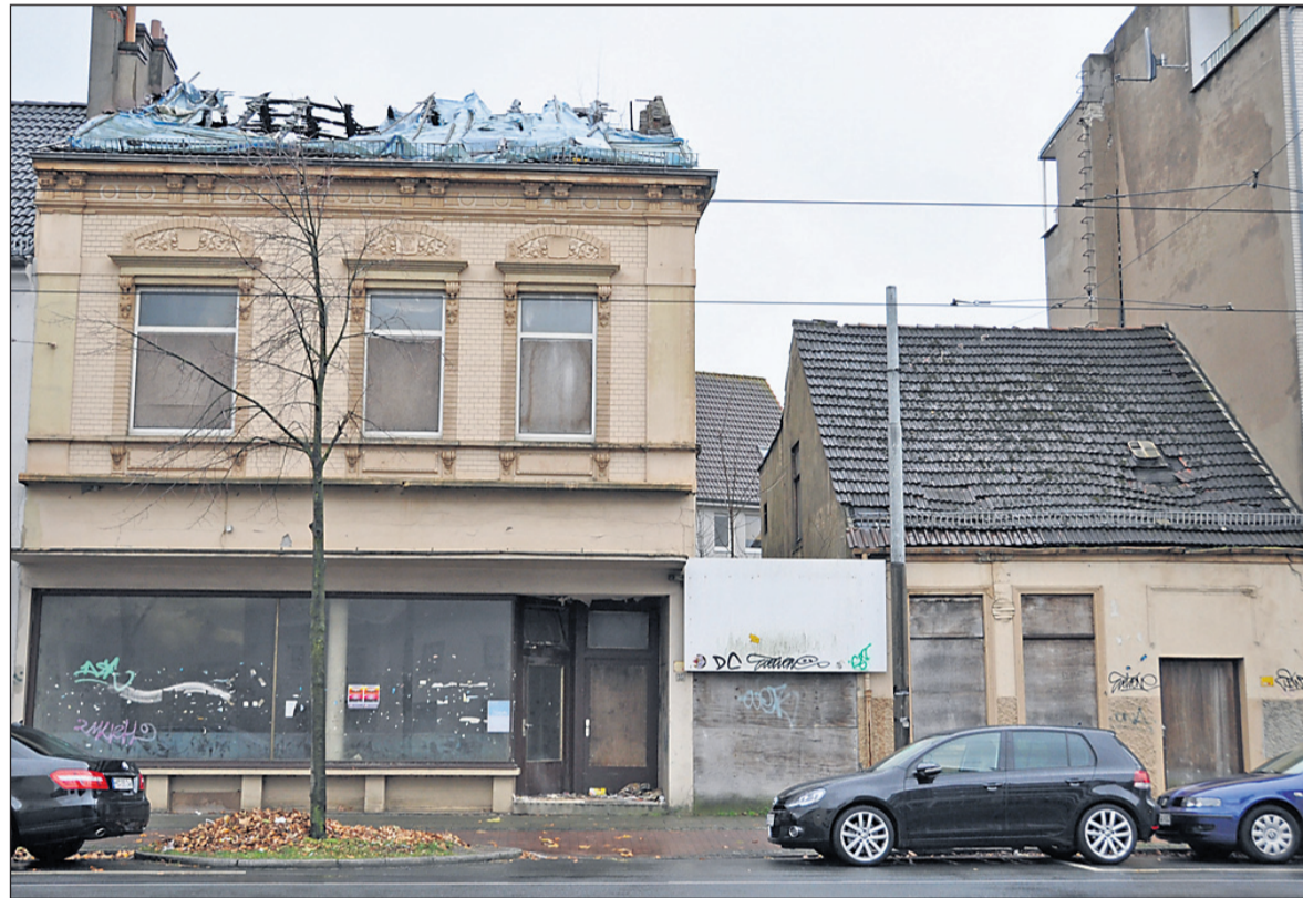
Das Haus an der Hastedter Heerstraße 35 verfällt. Der Dachstuhl ist abgebrannt, die Zwischendecke eingestürzt. Auch das Dach des Nebengebäudes hat sich gesenkt. Foto: Kemp
