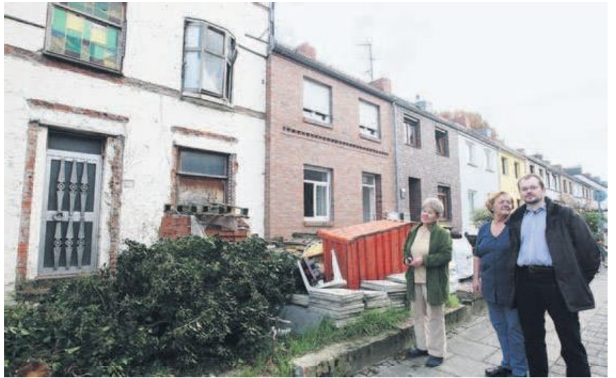
Schrottimobilie in der Jadestraße: In dem verfallenen Haus, das voller Unrat steckt, tummeln sich Ratten. Auch der Vorgarten ist eine Müllhalde. Die Nachbarn (von links) Else Esselborn, Angelika Bathmann und Dieter Steinfeld sind genervt und fühlen sich im Stich gelassen. FOTO: JOCHEN STOSS
