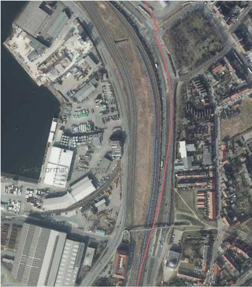
Fußgängerbrücke zur Kap-Horn-Str.. Im Bild 2 wird mit der dort in der Bildmitte laufenden Hundeführerin die Dimension der Fläche deutlich.
