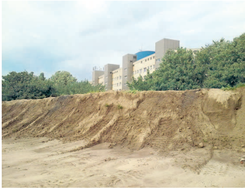
Immer höher und länger türmen sich seit Monaten die Erdmassen an den Bahngleisen entlang der Wohnsiedlung Wohlers Eichen. Nun die Überraschung: Das Ganze soll offenbar ein Schutzwall für die Anwohner werden. FOTOS: ROLAND SCHEITZ(2), DIETER STEINFELD (1)
