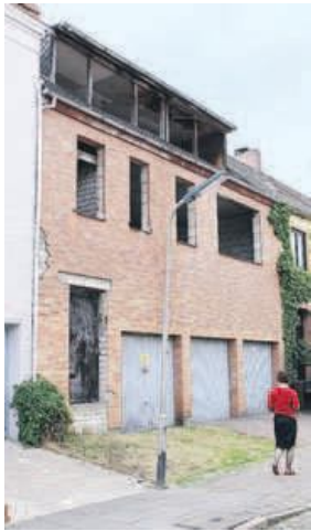
Das Haus in der Meyenburger Straße (links) ist kein Einzelfall. Auch in der Jadestraße, der Marfeler Straße und der Geeststraße (von links) verfallen seit Jahren Wohnhäuser.
